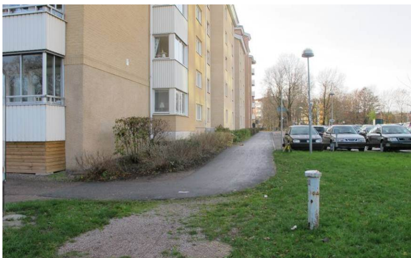
Foto som visar hur befintligt gångstråk fortsätter runt kvarteret Edda mot Svartbäcksgatan.
